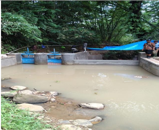
Lokasi DAM Parit Desa Sukaluyu, Kec. Nanggung, Kabupaten Bogor (20/11/2020)
