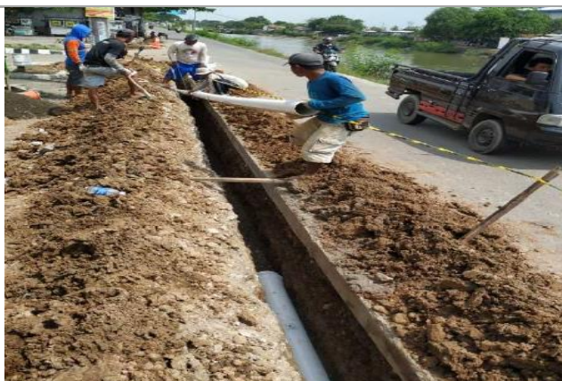
Dokumentasi Proyek SPAM Jl. Inspeksi Johar - warung bambu, kec. Karawang wetan, Kabupaten Karawang.
