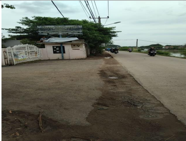
Lokasi SPAM Jl. Inspeksi Johar - warung bambu, kec. Karawang wetan, Kabupaten Karawang (26/11/2020)
